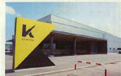
2021年竣工の新工場
